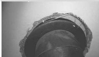
niewłaściwe podłączenie do czopucha – nieszczelne i brak możliwości czyszczenia
