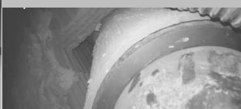
niewłaściwe podłączenie przewodu spalin i brak dylatacji czopucha
